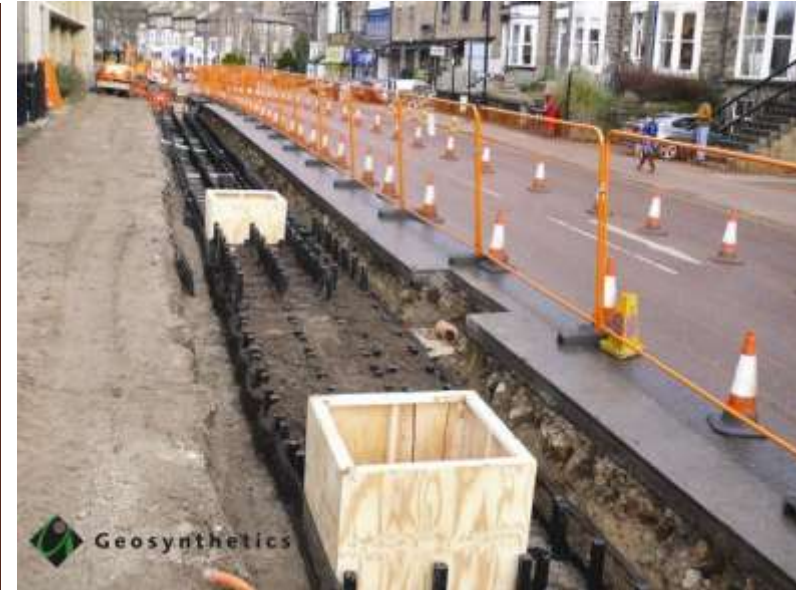
תאי סילבה – מאפשר צמיחה של שורשים בתוך תשתית, בשימוש בכ 30 מדינות
